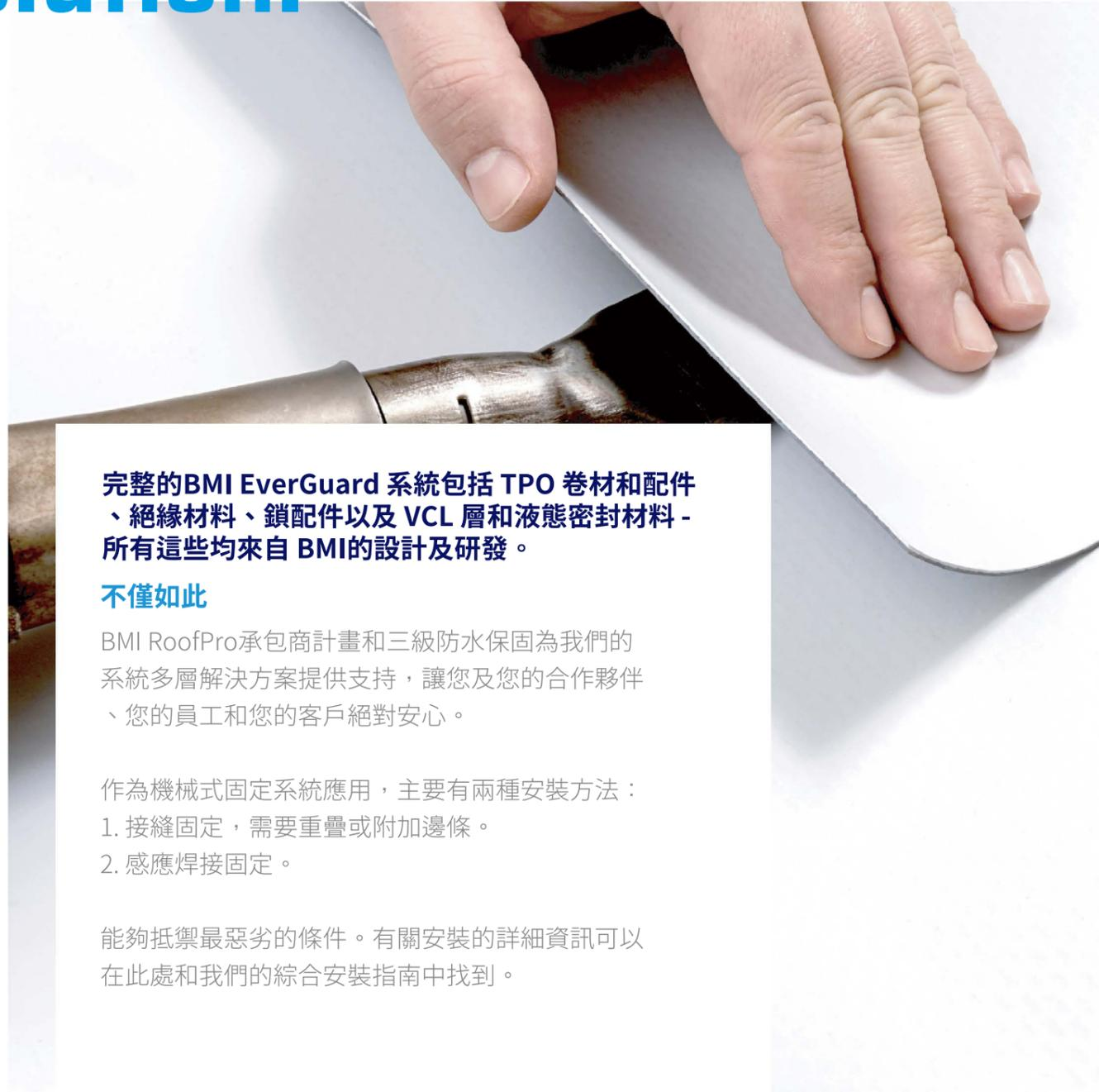
**完整的BMI EverGuard 系統包括 TPO 卷材及配件、絕緣材料、鎖配件以及 VCL 層和液態密封材料 - 所有這些均來自 BMI 的設計及研發。**
